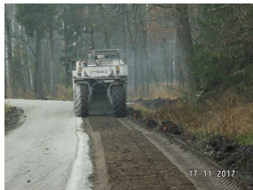
DP 1396N w trakcie przebudowy
