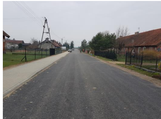
DP 1559N w trakcie przebudowy
