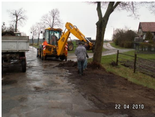
Ścinka zawyżonego pobocza w msc. Węgoryty
