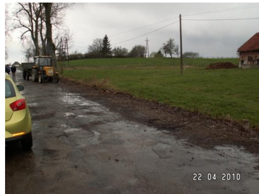
Ścinka zawyżonego pobocza w msc. Węgoryty
