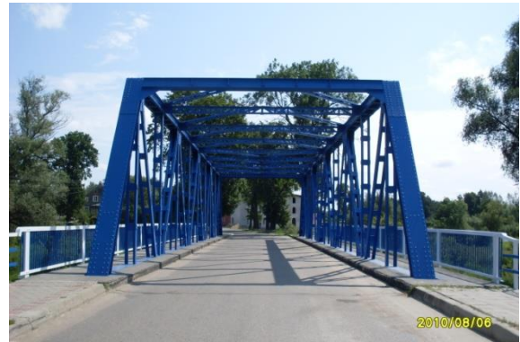
Konstrukcja mostu przed i po malowaniu
