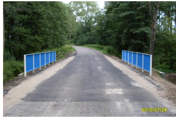
Przebudowa mostu na przepust
