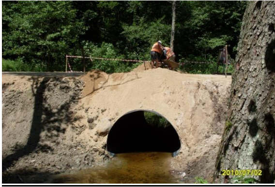
Przebudowa mostu na przepust
