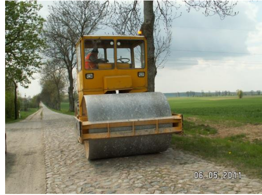
Poprawa nawierzchni z brukowca koło msc. Śmiardowo
