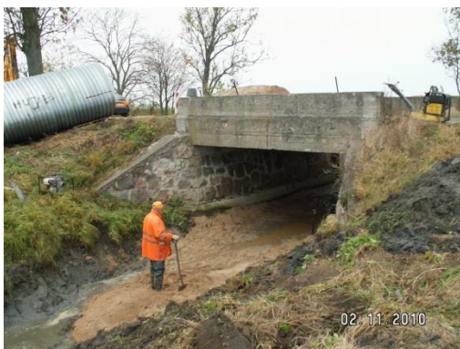
Przebudowa mostu na przepust k/m. Dzietrychowo
