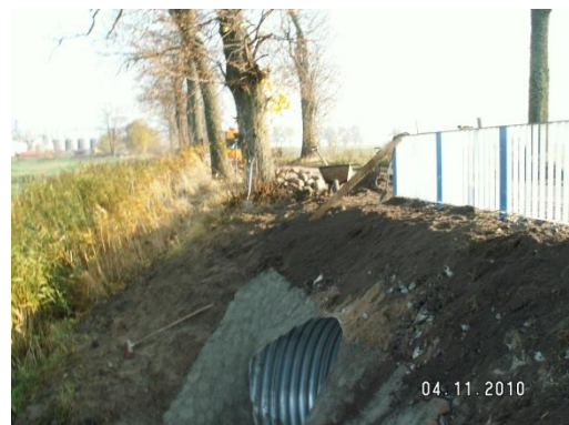
Przebudowa mostu na przepust k/m. Dzietrychowo
