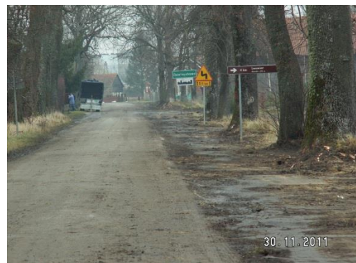
Ścinka zawyżonego pobocza koło msc. Dietrzychowo
