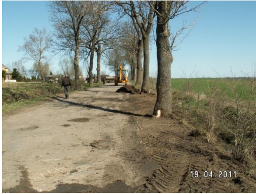
Ścinka zawyżonego pobocza koło msc. Grzęda
