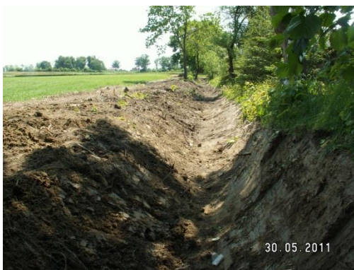
Odnowa rowów przydrożnych
