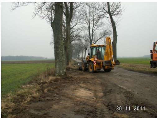
Ścinka zawyżonego pobocza koło msc. Dietrzychowo
