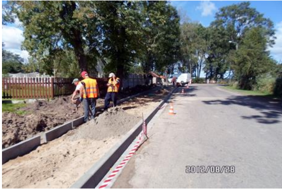
Budowa chodnika i zatoki autobusowej w msc. Witki
