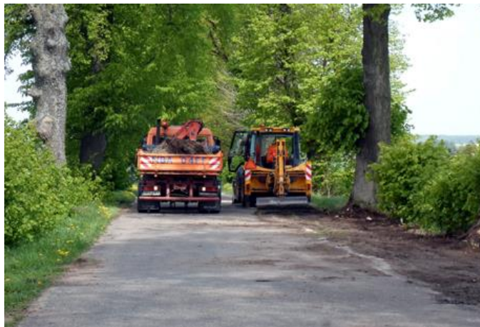
Ścinka zawyżonych poboczy DP 1400N odc. Dębiany - Maszewy
