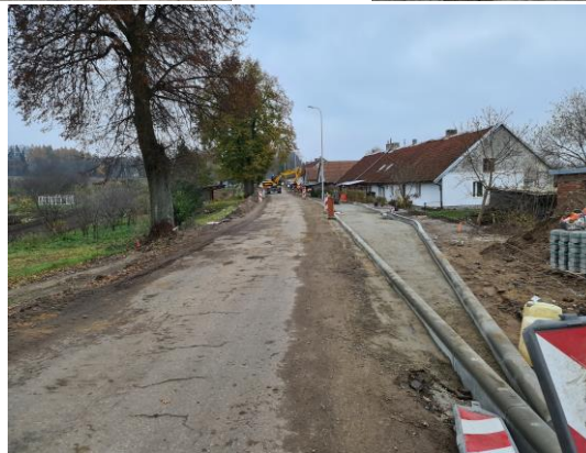
DP 1354N w trakcie przebudowy
