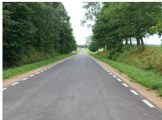
DP 1380N w trakcie i po przebudowie
