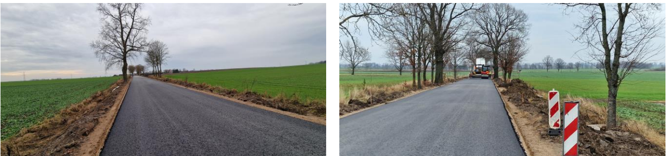
Przebudowa DP 1390N na odcinku Turcz – Sępopol
