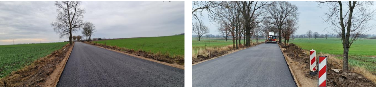
Przebudowa DP 1390N na odcinku Turcz – Sępopol
