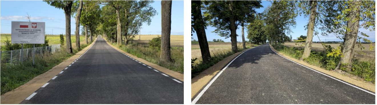
Przebudowa DP 1956N na odcinku Grzęda – Łędtawki
