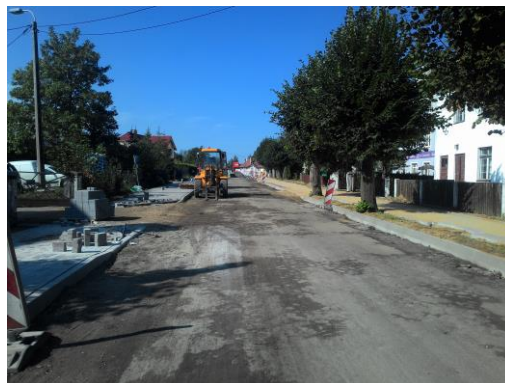
DP 2609N i 2597N w trakcie przebudowy
