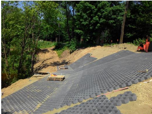
DP 1392N zabezpieczenie skarpy
